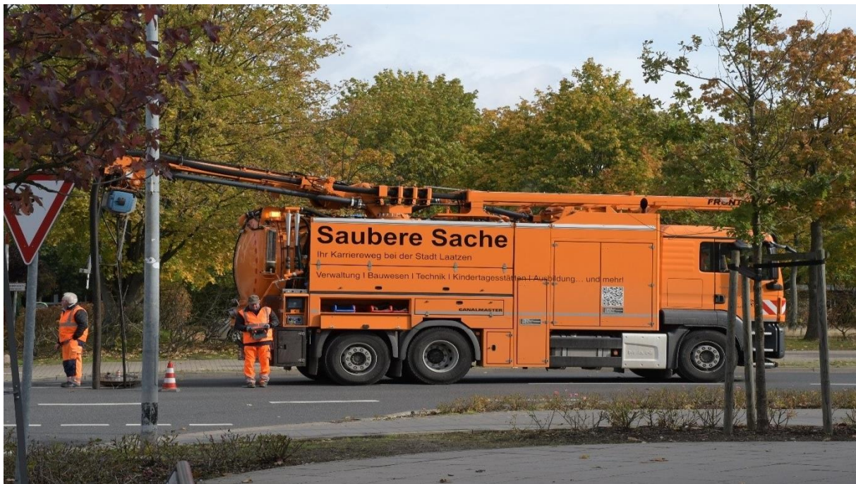
Kanalspülgerät Stadt Laatzten
